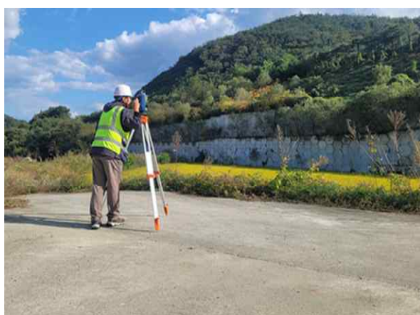
광파기를 이용한 측량 작업
