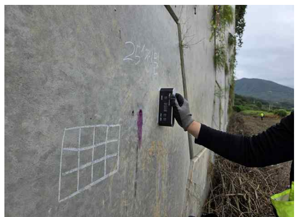
경사계를 이용한 경사도 측정
